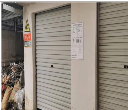
危险废物堆场外景
