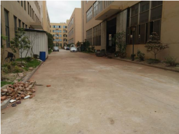
项目西侧现状
